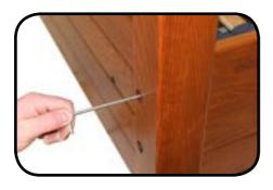
7. Die Schrauben an den Eckpfosten (8 Schrauben) festdrehen.
